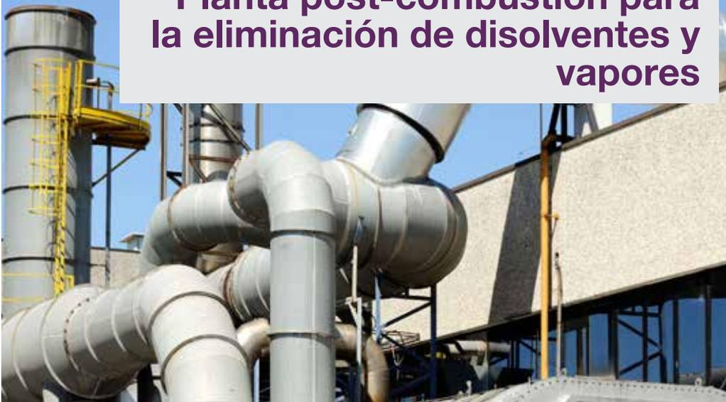
**Recuperación de calor mediante intercambiadores aire-agua y aire-aceite**
